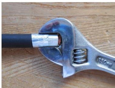
圧着端子の導線部分をレンチではさみ、圧着するときに「(上下の)幅」が広がらないようにしました。
